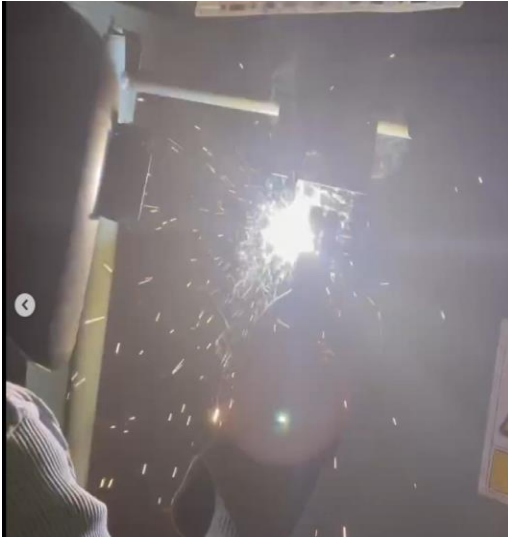
Fig. 9.3. Soldadura en posición 2G .
